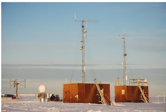
Abbildung 3 Treppentürme der Station Neumayer II, Februar 2008 (Foto: Alex Riess) 2
